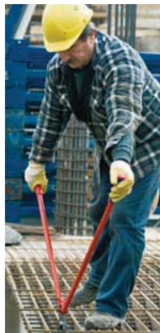
Особая форма головки ножниц для резки арматурной сетки 71 82 950 позволяет резать плотно прилегающую арматуру
