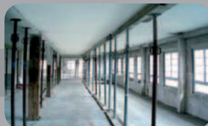
Поддержка несущей конструкции во время установки: Прогиб может быть исправлен.
