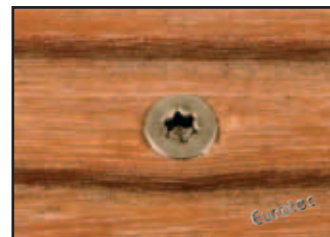
Предварительное сверление + шуруп Terrassotec
