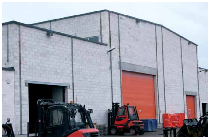
Производственный корпус завода AEROC (кладка из газобетонных блоков без наружной отделки). Пос. Андыя, Эстония.
